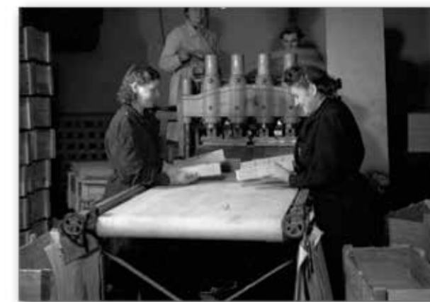
8 Maszyna i taśma do stemplowania mydła przemysłowego (wybijanie przedwojennego znaku firmowego SCHICHT), fot. PAP/CAF Machine and stamping tape for industrial soap (stamping the pre-war Schicht company seal), photo: PAP/CAF
