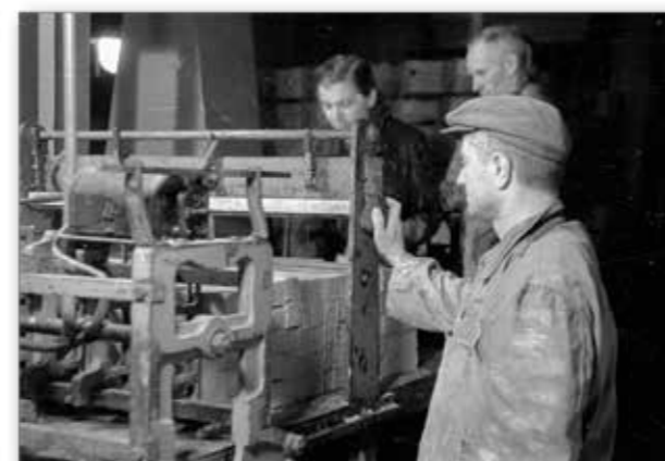
7 Tafle mydła krojone są na tzw. rygle, które następnie składa się w suszarni, a potem dzieli na mniejsze kawałki i odbija znak produktu, na zdjęciu – krajalnica, fot. PAP/CAF Soap slabs were later cut into logs which were later stored in the drying room, and later cut into smaller pieces and marked with the product's stamp, the photo shows a slicer, photo: PAP/CAF
