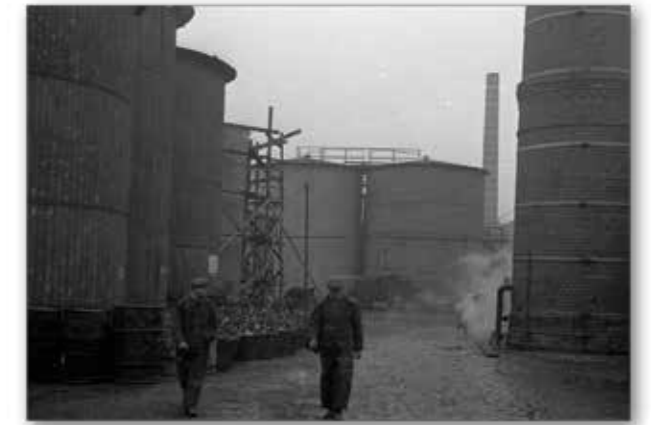
18 Silosy na płynne substancje, fot. PAP/CAF Silo for liquid substances, photo: PAP/CAF
